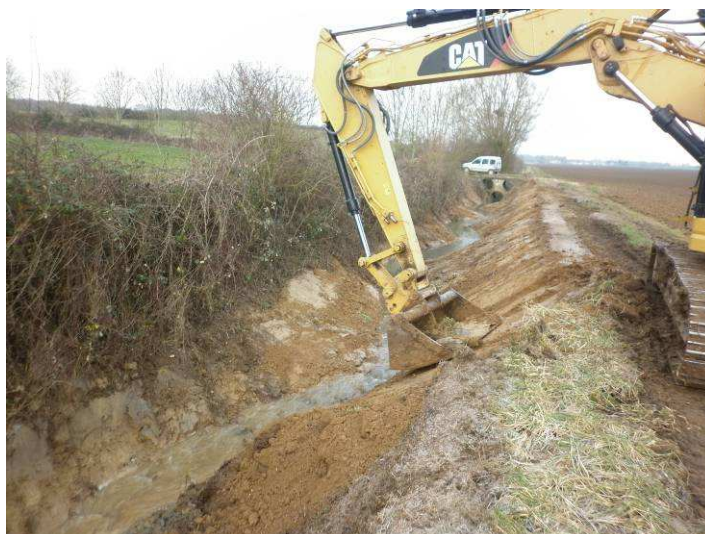
Création de méandres à l'intérieur du chenal d'écoulement
