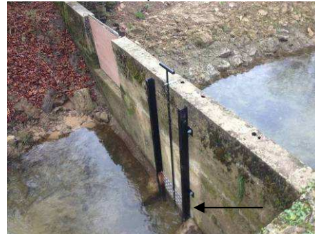
Abaissement de la prise d'eau
