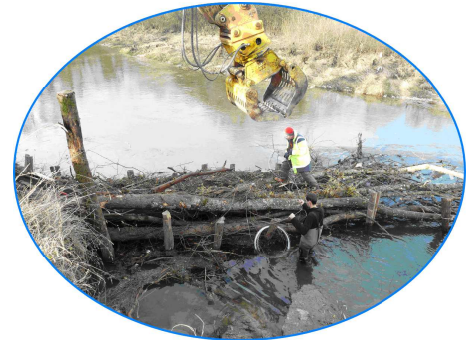
Mise en place des éléments végétaux à la pelle mécanique
