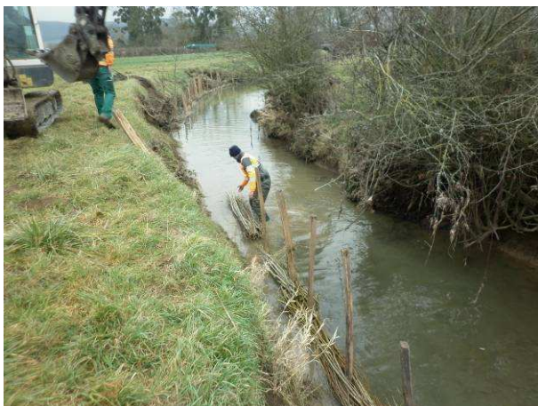
Mise en place de fascine en pied de berge / Création d'une banquette
