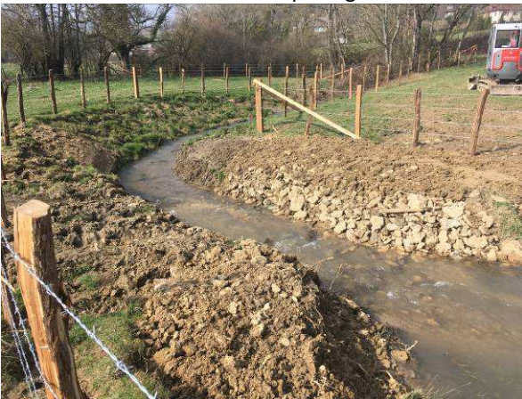
Ancien passage busé
