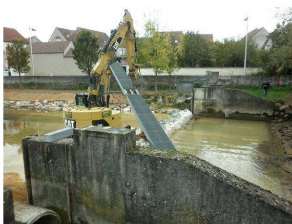
Retrait à la pelle hydraulique des éléments constituant l'ouvrage
