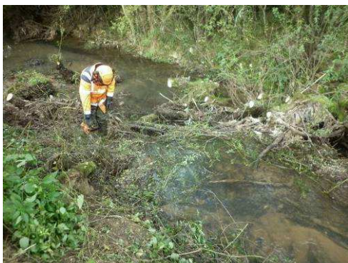
Seuil en fascine et grume avec encoche pour sa franchissabilité
