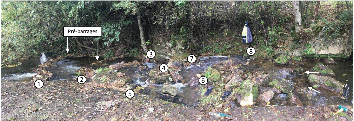
Vue panoramique après travaux
