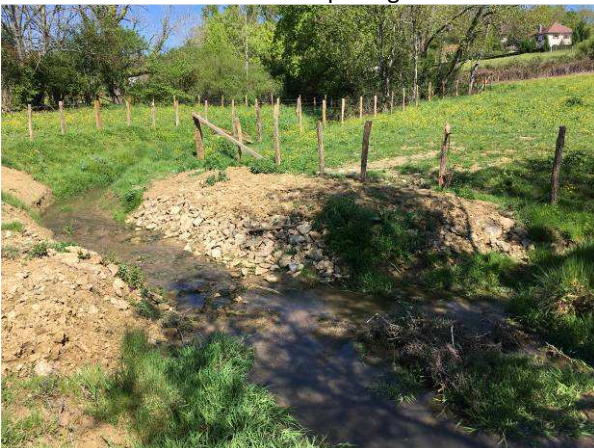
Ancien passage busé
