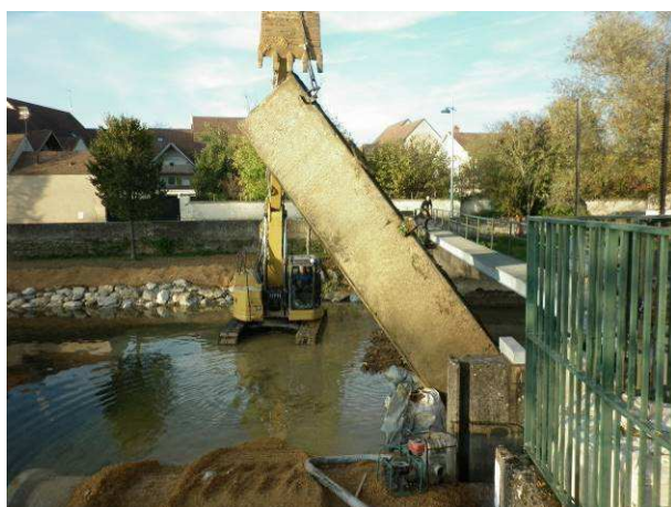
Retrait à la pelle hydraulique des éléments constituant l'ouvrage
