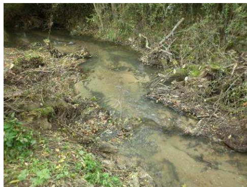
Entretien du bief et écoulement dans le bief après nettoyage
