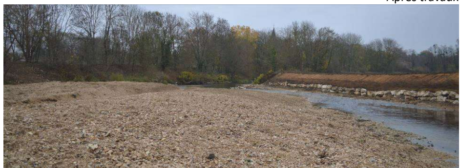
Vue de l'atterrissement scarifié et protection en rive droite
