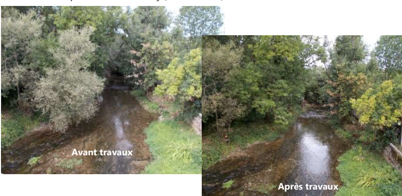
Vue amont du pont de Pont-de-Pany (octobre 2019)
