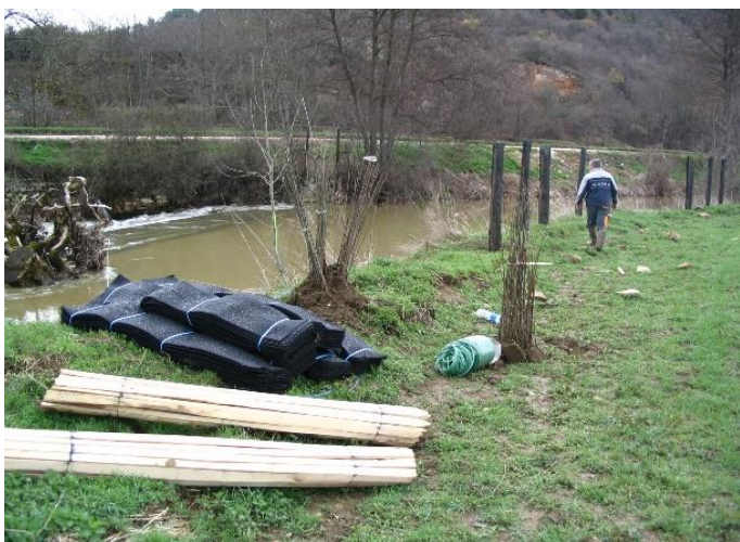
Chantier des plantations à Veuvey-sur-Ouche - 2006
