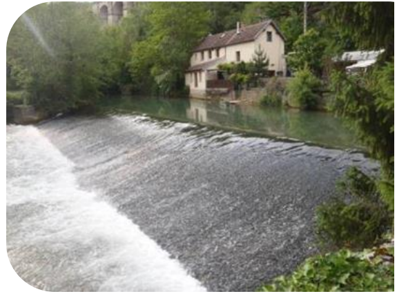
Déversoir de la Verrerie, 2013.
