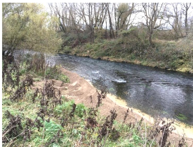
Après travaux (23 novembre 2021)
