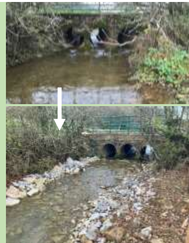
Restauration de la continuité par recharge sédimentaire en pied d'ouvrage
