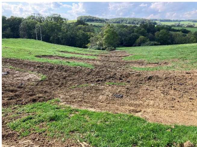
Création de bourrelets - juste après travaux à sec
