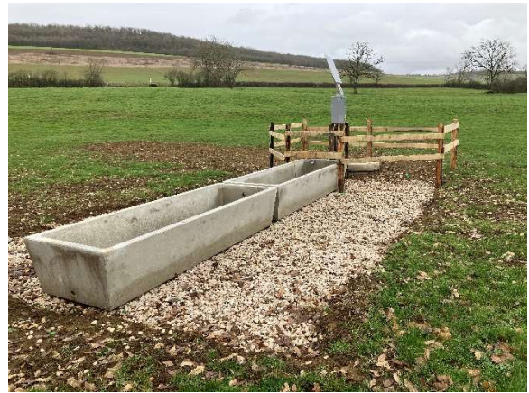
Puits / pompe avec panneau solaire
