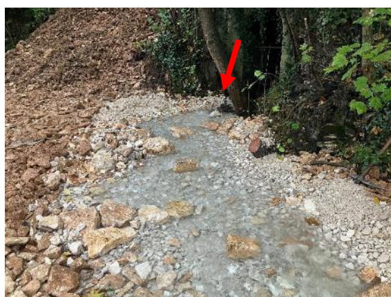
Après travaux (octobre 2023)
