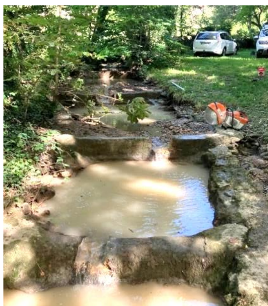
Août 2024 après travaux (débit plus faible)
