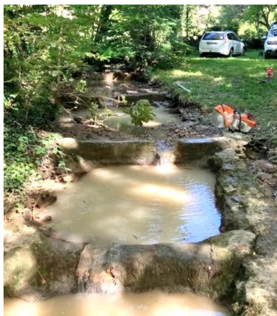
Août 2024 après travaux (débit plus faible)
