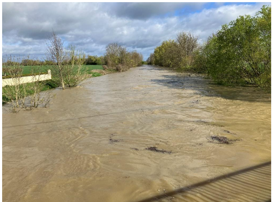
Vue vers l'amont du Pont de Varanges 2 avril 2024
