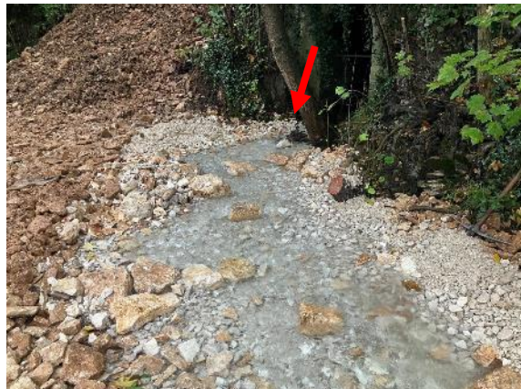
Après travaux (octobre 2023)
