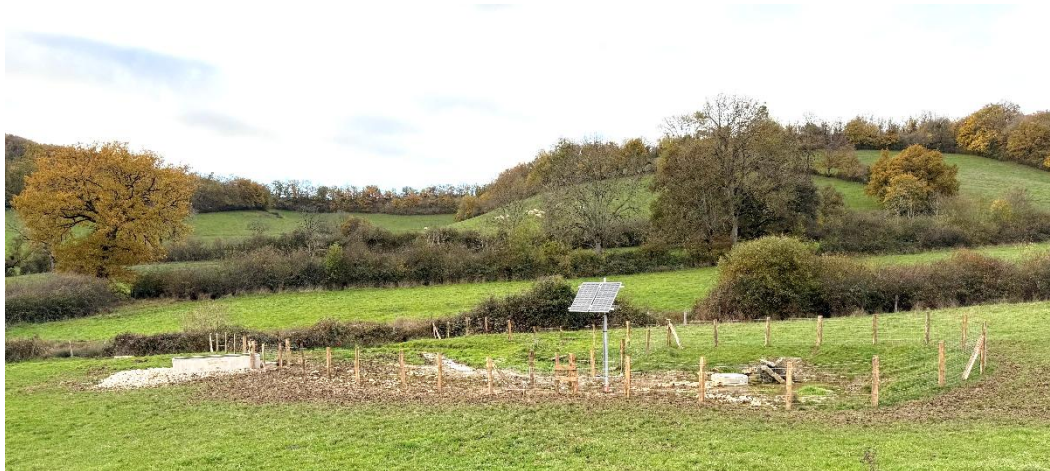
Après travaux : source protégée, abreuvoir déporté
