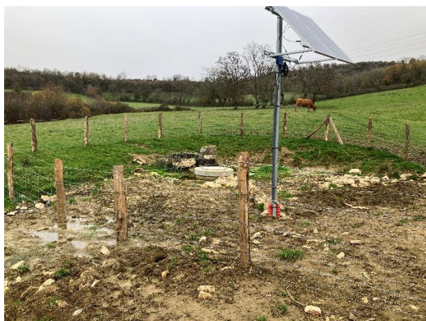
Source aménagée et clôture classique doublée d'une clôture à moutons pour protéger l'aménagement des sangliers – A droite : Ecoulement de la source avant reprise de la végétation.
