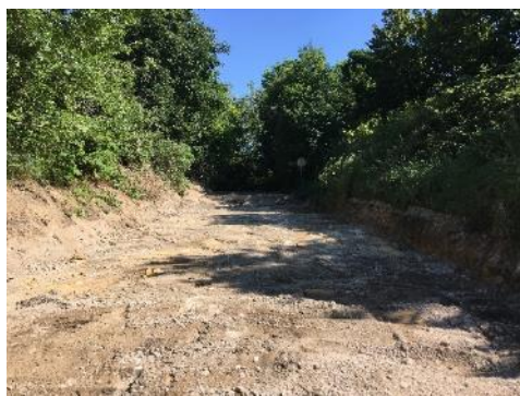
Section du Suzon au droit du piège à flottant après extraction des sédiments (juillet 2018).
